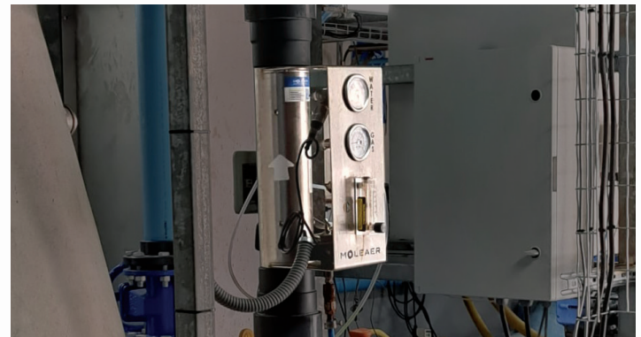
Grafica 2. Equipo Trinity L1 instalado verticalmente
