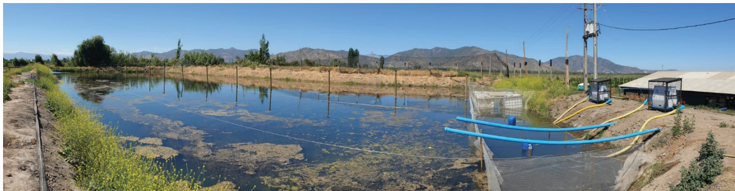
Octubre del 2020, al momento de la instalación.
