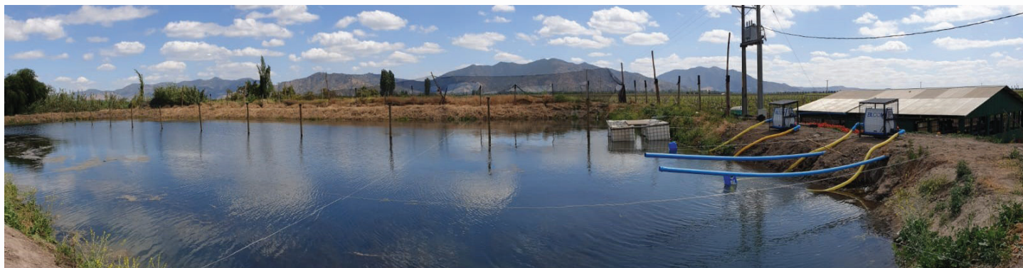
Febrero del 2021, 4 meses después de la instalación.
