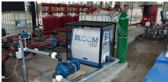
El generador de nanoburbujas Bloom 150 de 5.67 m³/h (metros cúbicos por hora) de Moleaer se instaló junto a un tanque de agua de riego para el tratamiento continuo del agua durante la prueba.
