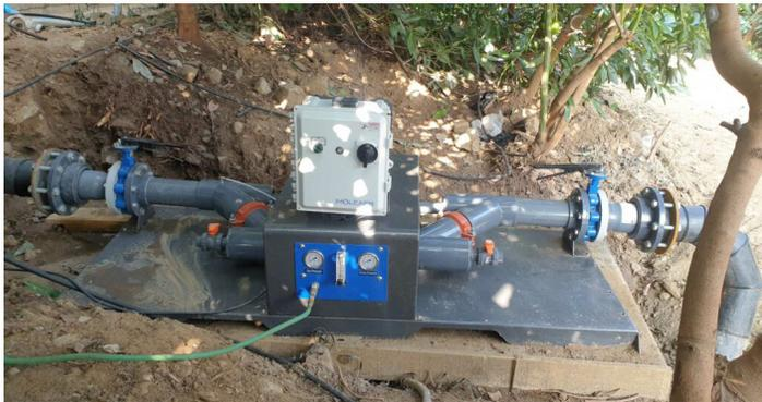
Generador de Nanoburbujas Nexus™ de Moleaer instalado en línea con los sistemas de riego existentes para sobresaturar el agua de riego con nanoburbujas a través de las líneas de riego por goteo.
