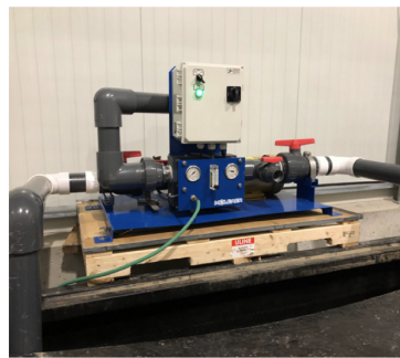
El generador de nanoburbujas de Moleaer es fácil de instalar y se integra rápidamente en los depósitos y sistemas de riego existentes para aumentar los niveles de oxígeno disuelto en el agua de alimentación
