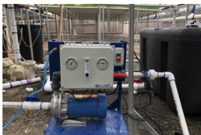
El generador de nanoburbujas Moleaer es fácil de integrar en un sistema hidropónico existente.
