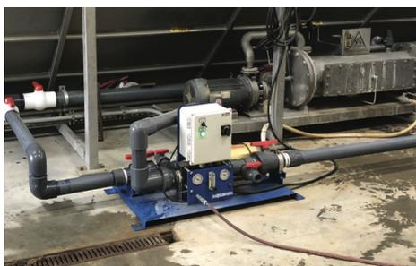
El generador de nanoburbujas de Moleaer se integra perfectamente en el DAF existente.
